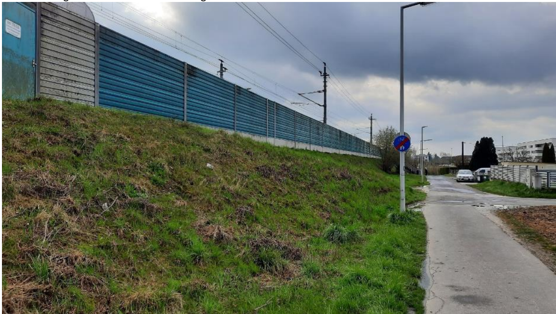
Böschung S17 (alt 1073) liegt nördlich der Westbahn und wurde im Zuge der Bahnerhaltung erneuert
